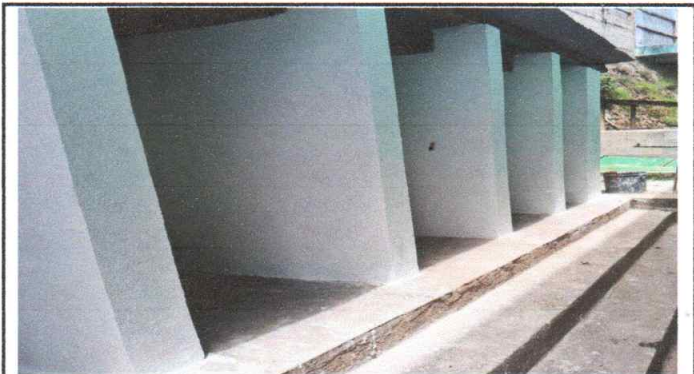
Foto 4: aplicación de repello de servicio sanitario
