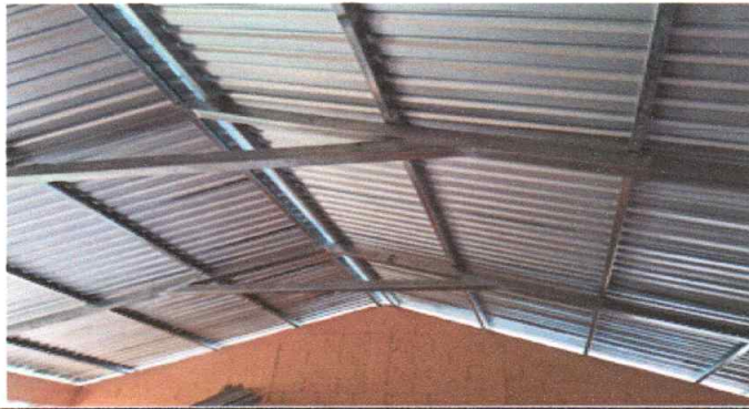
Foto 7: sustitución de lanima por lamina troquelada aluzinc calibre 26
