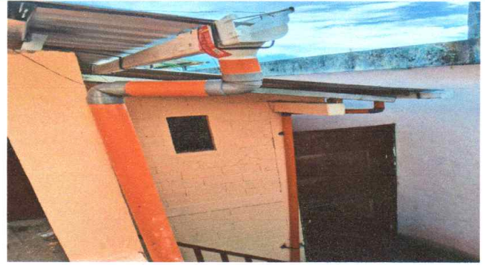
Foto 8: sustitución de canales y bajadas de agua pluvial
