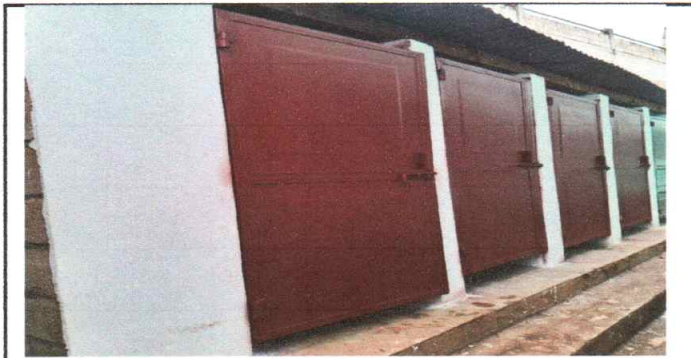
Foto 3: sustitucion de puertas en servicios sanitarios
