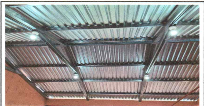
Foto 6: reparacion de sistema electrico
