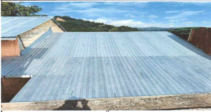
Foto1: sustitución de lanima por lamina troquelada aluzinc calibre 26
