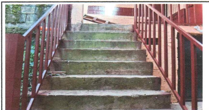
Foto 5: sustitución de barandas
