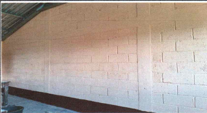
Foto 9: Pintura en muros exteriores e interiores
